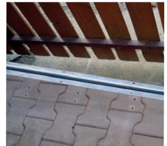
montáž SR-kabelu do pojezdové kolejnice vrat
