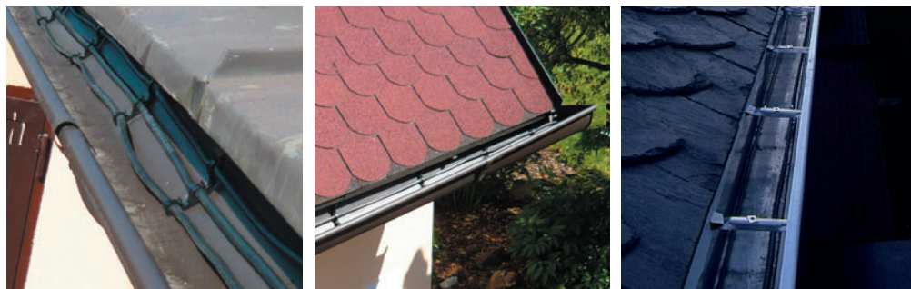
ukázky z realizací montáže topných kabelů na RD
