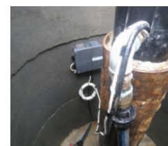
použití hladinového spínače ve studni
